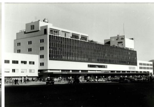
完成した広島民衆駅
