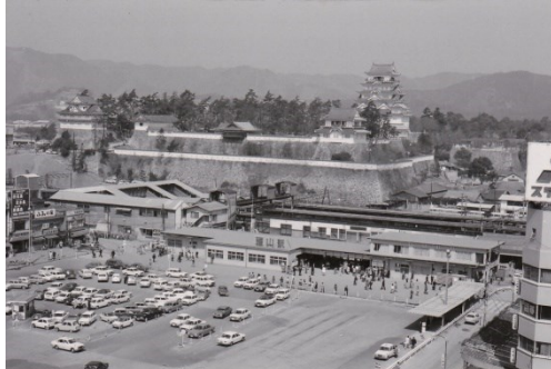
新幹線工事で仮営業中の福山駅
