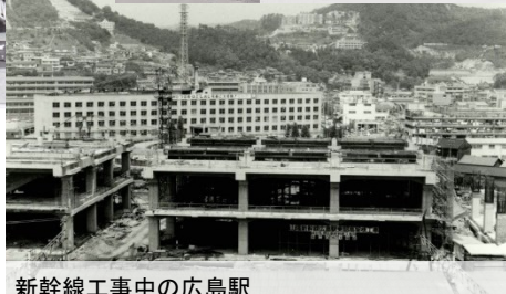
新幹線工事中の広島駅
