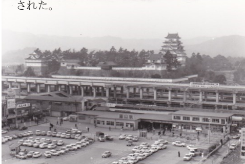
新幹線高架工事中の福山駅
