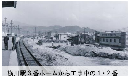
横川駅 3 番ホームから工事中の 1・2 番ホームを望む
