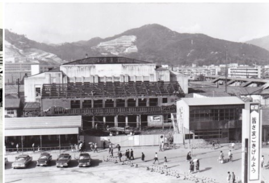
工事（解体）中の広島駅と仮駅
