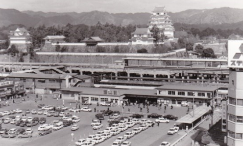
新幹線高架工事中の福山駅
