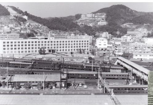
新幹線工事以前の広島駅
