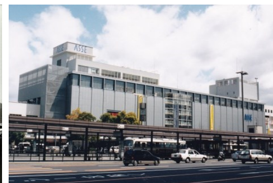
新装なった広島駅ビル「アッセ」
