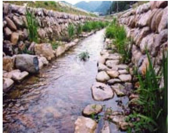
【整備後の石積水路】
