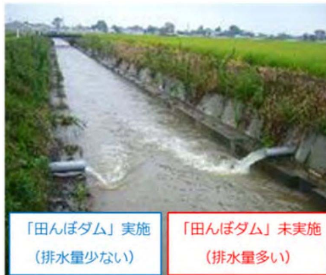
「水田貯留」を実施している水田の排水イメージ
