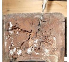
写真1 腐朽しやすいところ，たたく点検，ドライバーで刺す内部の腐朽点検
