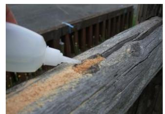
写真 2 亀裂の補修
