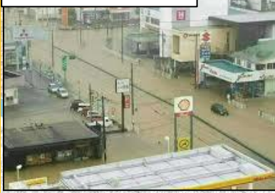
蔵王町: 国道182号沿線 (平成30年7月浸水状況)
