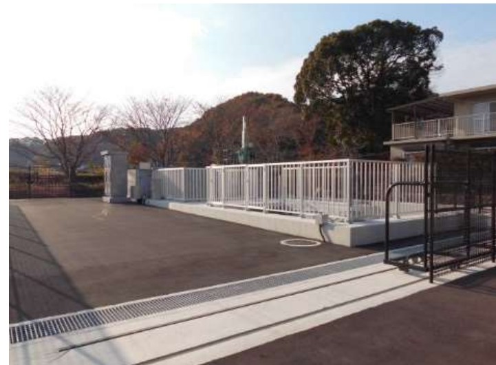
令和4年6月完成
