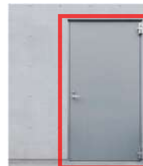
防水扉の設置
