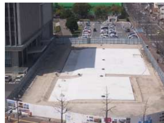
施設全景(工事中)
