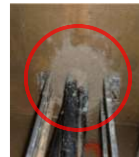
ケーブル貫通部の閉塞
