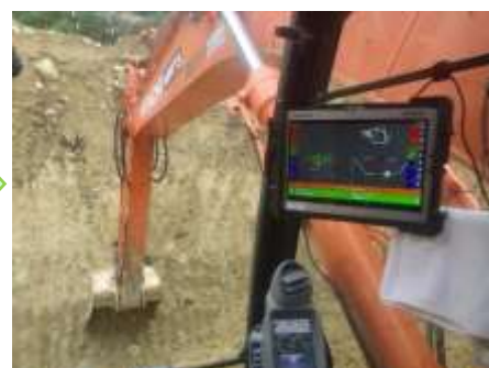
ICT建機による掘削
