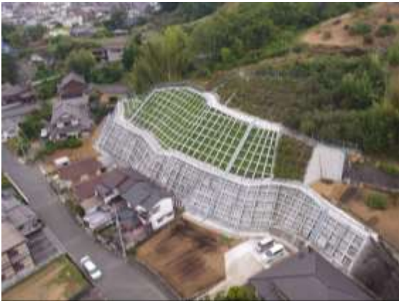
急傾斜地崩壊防止施設の整備
