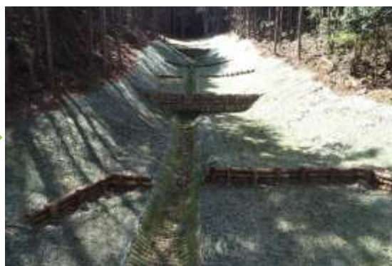
山腹工 施工後の状況(令和5年3月撮影)
