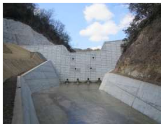
砂防堰堤の整備
