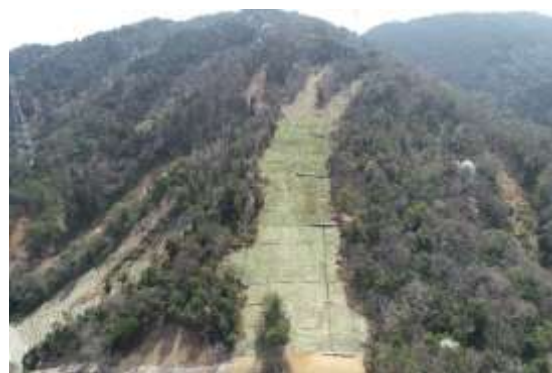
山腹工 施工状況(令和5年3月撮影)
