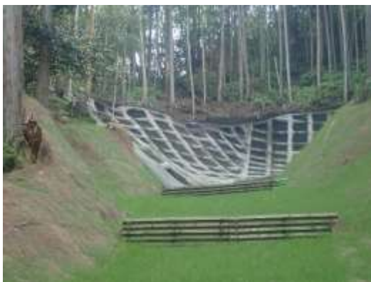
山腹工 施工後の状況(令和5年3月撮影)
