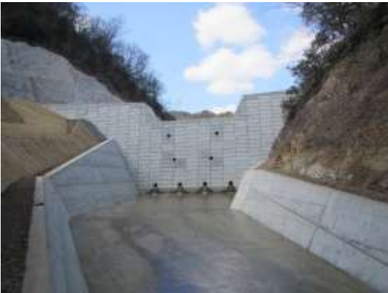
砂防堰堤の整備
