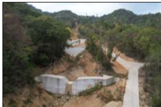
溪間工 施工後の状況(令和6年11月撮影)
