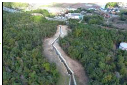
溪間工 施工後の状況(令和6年11月撮影)
