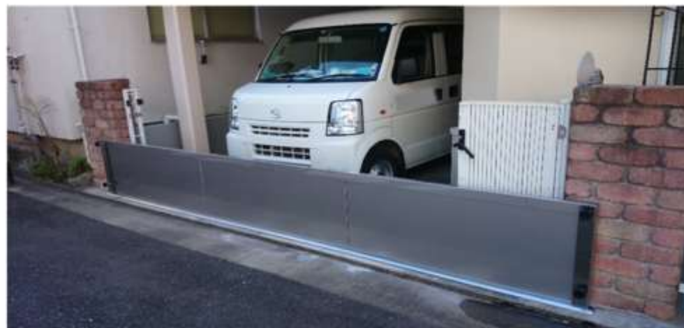
【止水板の設置例】
