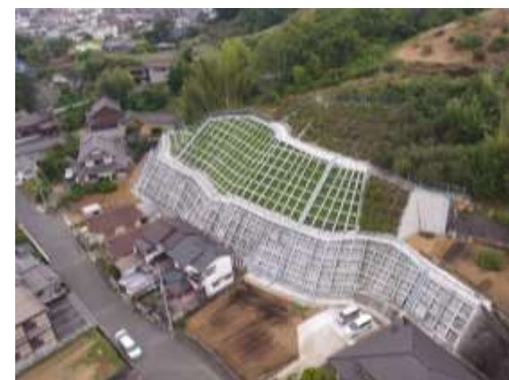
急傾斜地崩壊防止施設の整備
