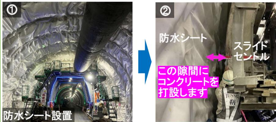
①トンネル内部に水が回らない様に防水シートを設置します。
