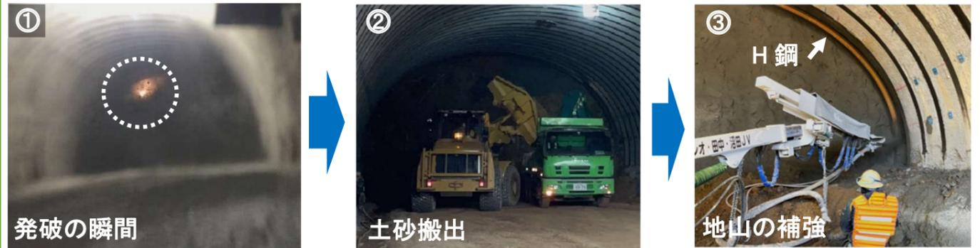
①火薬を設置し発破します。②崩れた土砂を搬出します。③掘削後の天井や壁をH鋼やコンクリートなどで補強します。①～③までの作業で約1.0～1.2mの掘削が進捗します。鞆未来トンネルは2,114mなので、約2,000回の作業を繰り返して完成しました。
