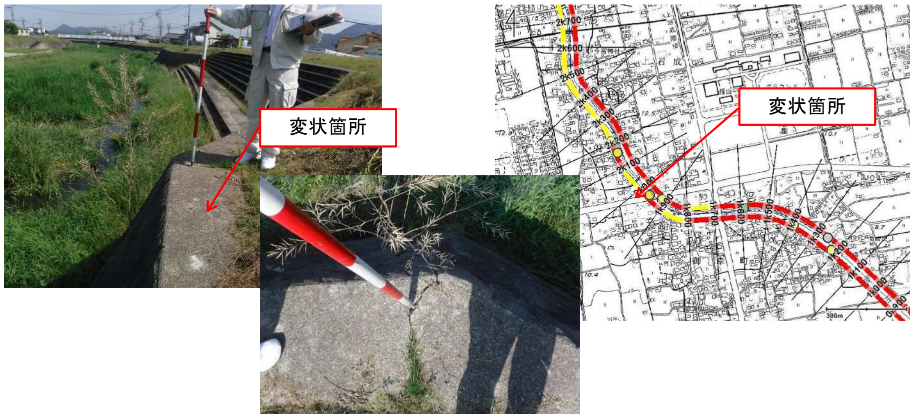
堤防点検の様子（加茂川 令和5年5月）
