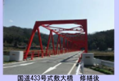
国道433号式敷大橋 修繕後
