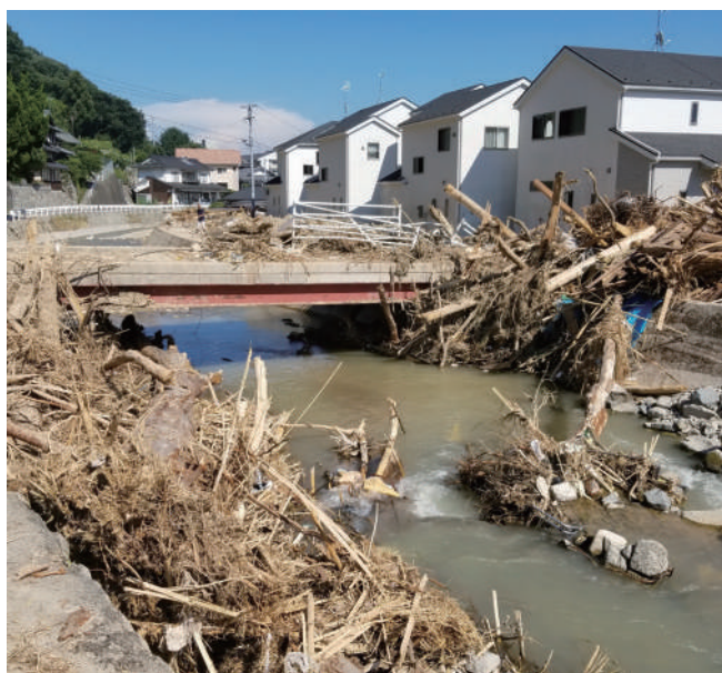
りゅうぼく はし はんらん はっせい くれ し やすうらちよう 流木が橋でつまり氾濫が発生(呉市安浦町) しゅってん ひろしま だいがく ぼうさい げんさい けんきゅう 出典:広島大学防災・減災研究センター
