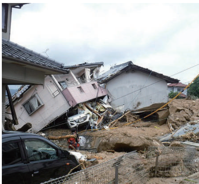
ど せきりゅう ひ がい あ き ぐんくまの ちよう 土石流による被害(安芸郡熊野町) しゅってん ち いき さ ぼうじょうほう 出典:地域の砂防情報アーカイブ
