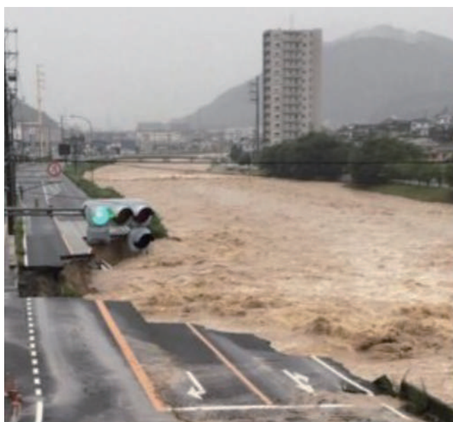
かわ そくかん どうろ りゅうしつ ひろしま し あ き く 川の側岸がけずられ道路が流失(広島市安芸区) しゅってん ちようしゅうしん ぶんしや 出典:長周新聞社
