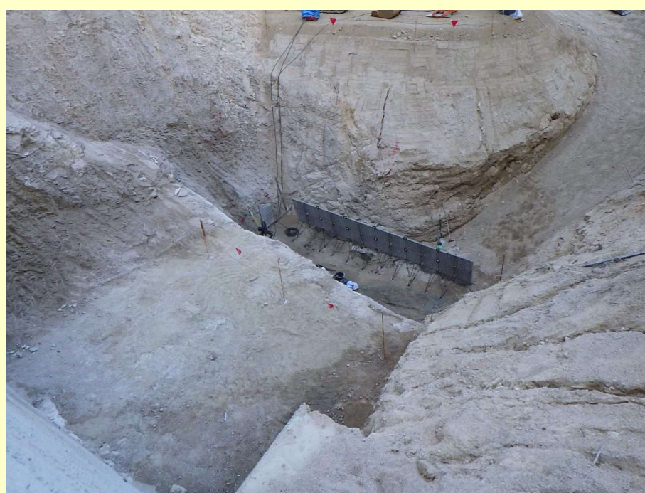
【掘削工(垂直壁部)】
