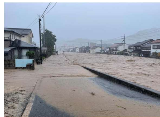
多治比川の浸水被害(安芸高田市)
