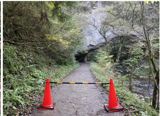
※通行止めの状況(奥に見えるのが雄橋)
