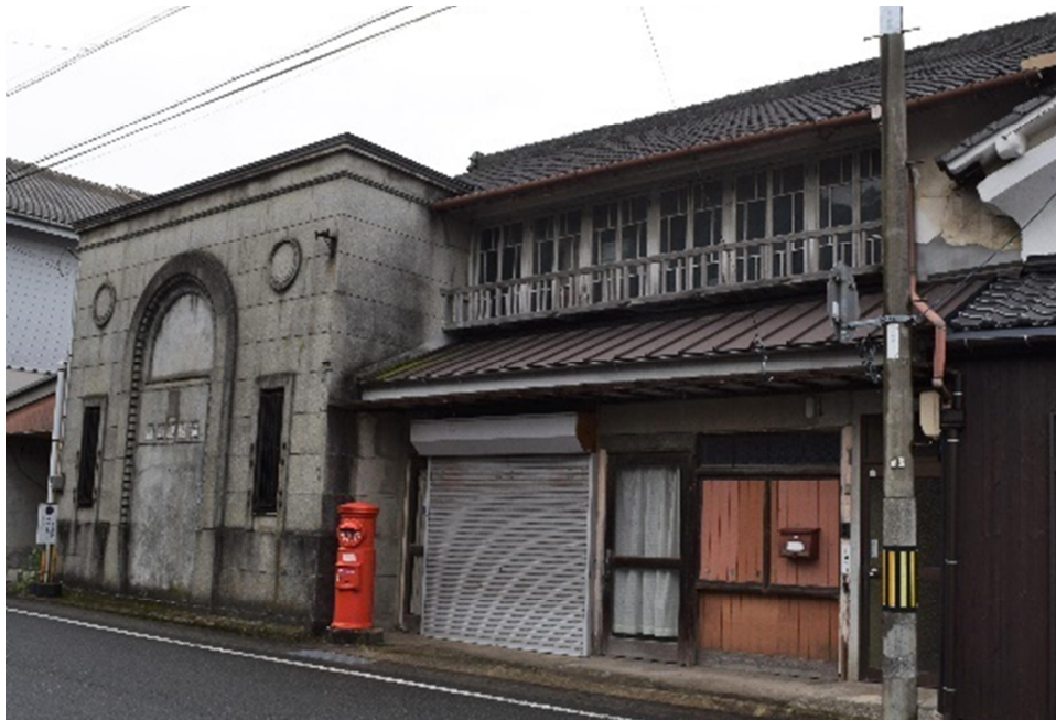
村井家住宅主屋（旧市村郵便局）（北東外観）
