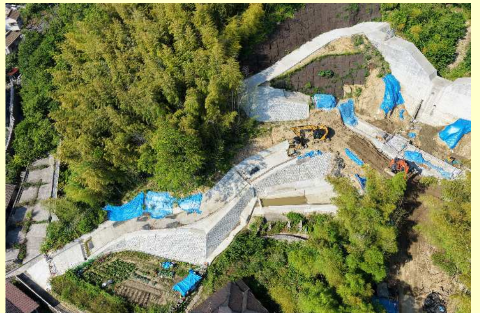
【掘削工(副堰堤部)】
