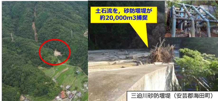
○石積砂防堰堤の被災
