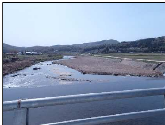
河川浚渫状況
