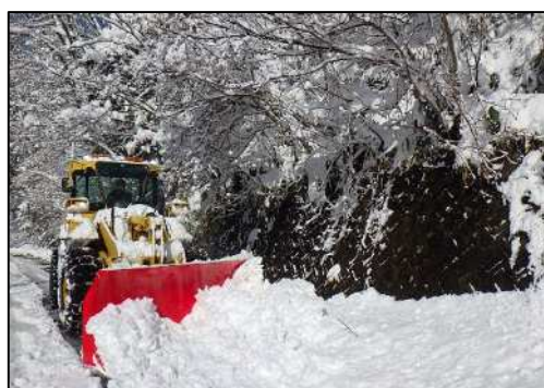
道路除雪状況
