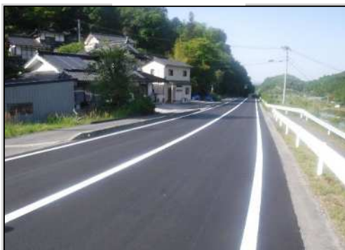
道路舗装補修状況
