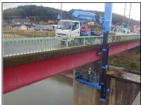
橋梁点検状況
