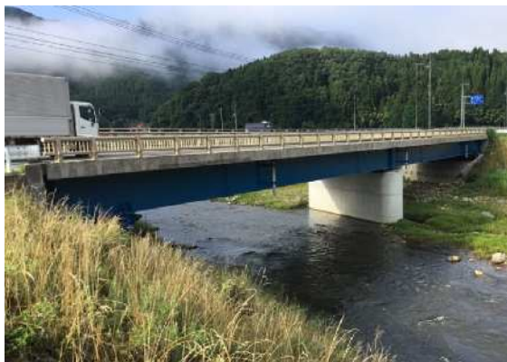
一般国道375号三若橋 三次市三若町
