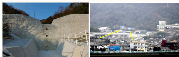
なかよころがわ 【中横路川（通常砂防事業）】
