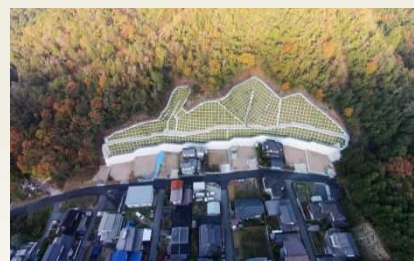
こずえだ 【梢台団地（急傾斜地崩壊対策事業）】
