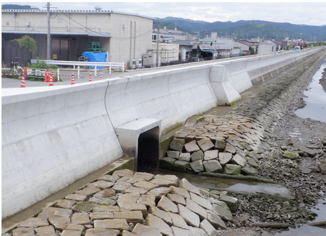
■ 耐震堤防による防護 / 福山市高西町南 尾道糸崎港海岸（高西地区） / 高潮・津波危機管理対策緊急事業
