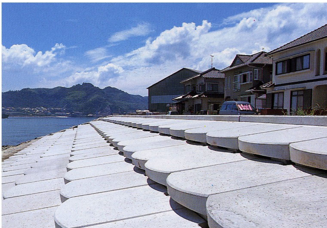
■ 緩傾斜護岸による防護 / 呉市警固屋 呉海岸（警固屋地区） / 高潮対策事業
